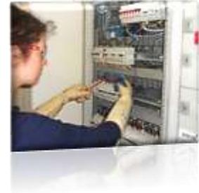
Le matériel utilisé est généralement des marques OMEGAWATT et KISTOCK, tous ces instruments sont non intrusifs, et ne nécessitent donc aucune coupure d'alimentation, l'intervention se limitant à d'éventuels démontages de capotages ou de plastrons. En particulier, les enregistrements sur les circuits électriques se font par l'intermédiaire de tores ouverts. De plus, ils permettent un retour sur un serveur distant pour suivre les enregistrements en temps réel.
