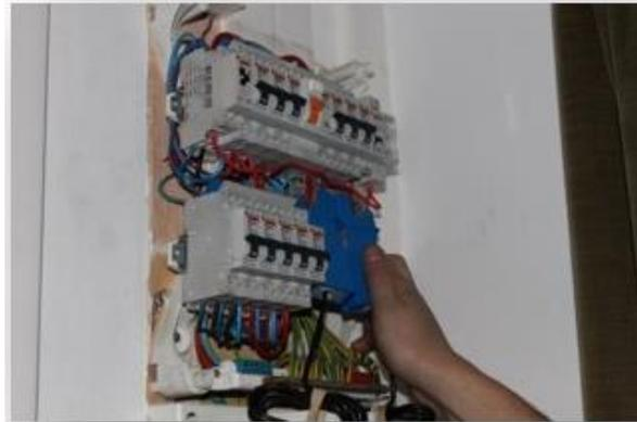
Figure 7 : Pince ampèremétrique et son installation dans un tableau électrique
